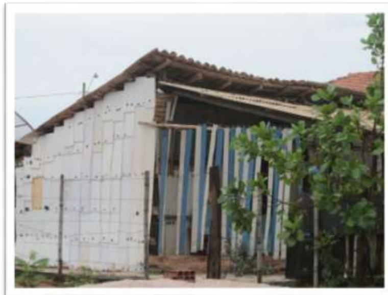
Figura 27: Casa construída com matérias recicláveis.
