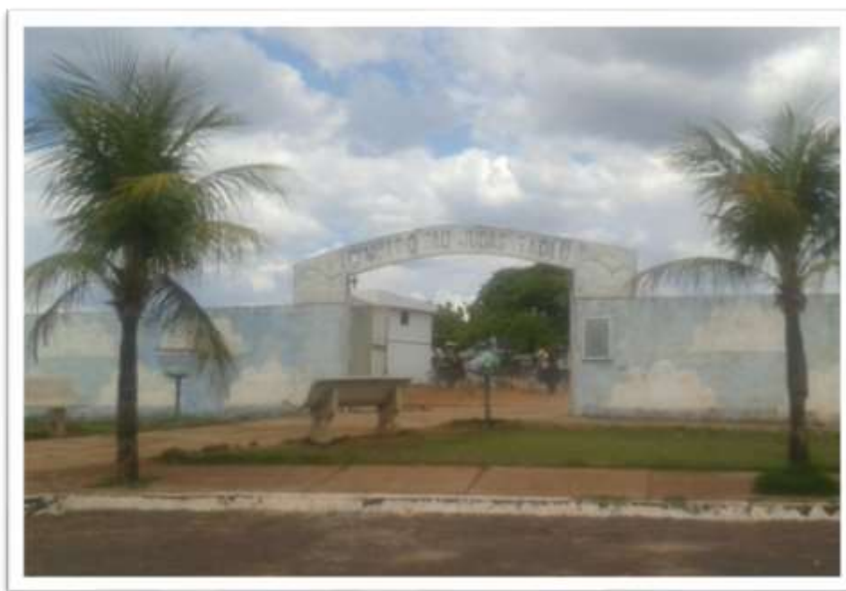
Figura 10: Cemitério São Judas Tadeu do município de Ponte Alta do Tocantins.
