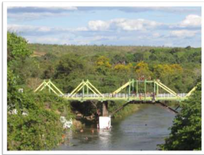
Figura 54: Ponte sobre o Rio Ponte Alta, no município de Ponte Alta do Tocantins.
