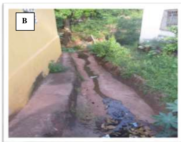
Figura 45: a) e b) Lançamento de esgoto doméstico ao sistema de drenagem pluvial.
